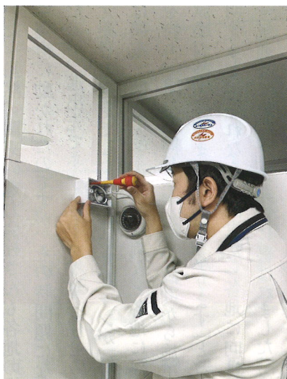
監視カメラの設置
