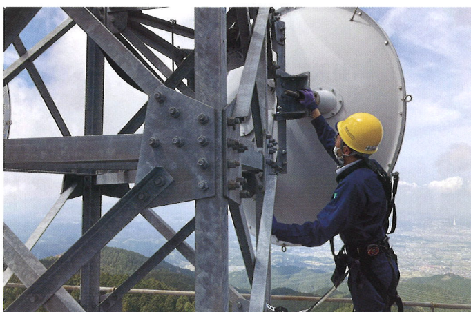
防災行政無線のアンテナ点検
